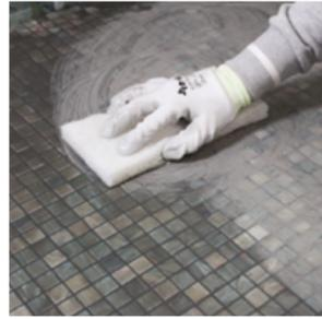
**5.** Nettoyer avec un feutre abrasif en effectuant un mouvement rotatif pour éliminer les résidus de mortier, en prenant soin d'émulsionner toute la surface de manière homogène.
