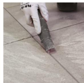
**1.** Les joints et le revêtement de finition (céramique, marbre, etc.) doivent être nettoyés au préalable. Les résidus de colle, poussière et parties friables doivent être soigneusement aspirés ; les joints doivent également être libres sur au moins 2/3 de l'épaisseur des carreaux (toute l'épaisseur en cas de carreaux fins).
