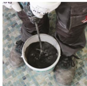
**2.** Verser FASSAFILL EPOXY Comp. B dans l'emballage de FASSAFILL EPOXY Comp. A ; mélanger soigneusement en utilisant un mélangeur hélicoïdal à faible vitesse jusqu'à obtenir un mélange homogène et sans grumeaux.
