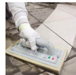
**4.** Attendre que FASSAFILL deviennent plus dense et que sa surface soit opaque (caractéristique obtenue après des temps variables en fonction de la porosité du support, de l'épaisseur et de la nature du carreau et des conditions ambiantes). Nettoyer avec une éponge légèrement humide, en la déplaçant toujours en diagonale par rapport aux joints, en prenant soin d'utiliser deux récipients d'eau, l'un pour nettoyer l'éponge et l'autre pour compléter le nettoyage à l'eau propre.
