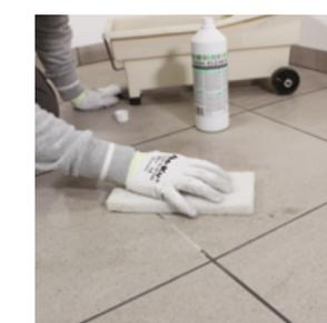
**6.** Diluer FASSA-CLEAN PLUS avec de l'eau en fonction du type et de l'importance des incrustations à éliminer (dilution de 1:1 jusqu'à 1:8). En cas de revêtements très absorbants, humidifier préalablement avec de l'eau. Appliquer FASSACLEAN PLUS de manière uniforme sur la surface à traiter, laisser agir 5 à 10 minutes, jusqu'à ce que les résidus soient ramollis.
