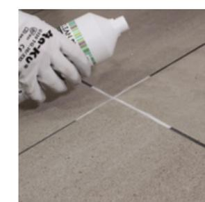
**5.** Dans le cas de surfaces résistantes aux acides, en présence de résidus ou halos de mortier au ciment, il est conseillé de nettoyer avec le détergent acide FASSA-CLEAN PLUS (après au moins 24 heures avec FASSAFILL RAPID, 7 jours avec les FASSAFILL à prise normale).
