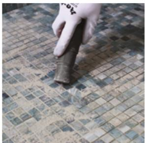
**1.** Les joints et le revêtement de finition (céramique, mosaïque de verre, etc.) doivent être nettoyés au préalable. Les résidus de colle, poussière et parties friables doivent être soigneusement aspirés ; les joints doivent également être libres sur au moins 2/3 de l'épaisseur des carreaux (toute l'épaisseur en cas de carreaux fins).
