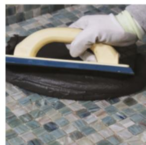
**4.** Appliquer le mélange avec une spatule caoutchoutée. Intervenir en diagonale par rapport aux carreaux, en prenant soin de remplir complètement les joints et d'enlever l'excès de matériau avec la spatule.
