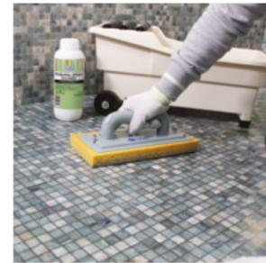
**7.** Si le jour suivant le nettoyage les carreaux présentent des halos ou des points collants, il est possible de nettoyer avec une éponge en cellulose et une solution de FASSAFILL EPOXY CLEANER et eau à 1:5. Pour les salissures plus persistantes et les résidus de mortier durcis, utiliser FASSAFILL EPOXY CLEANER pur dans les 24 heures suivant l'application ; après cette période, le produit ne peut être éliminé que mécaniquement.
