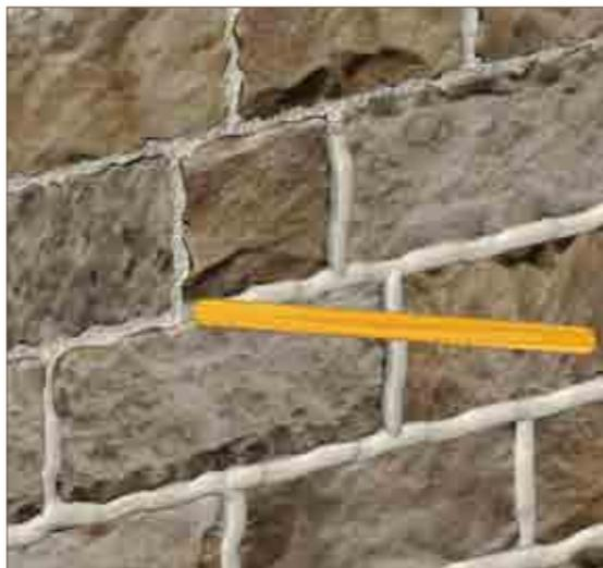
Le joint ne doit surtout pas être travaillé tant qu'il est souple. Ce n'est qu'après avoir obtenu une consistance assez dure (ou alors dès qu'il ne laisse plus de traces de salissures sur la peau si on le touche du bout des doigts) qu'on pourra pousser le mortier dans le joint à l'aide d'un petit bâton en bois, puis le répartir et le modeler à volonté. De cette façon, le mortier en excès se détache et tombe par terre sans tâcher les pierres, sous forme de grumeaux consistants et presque secs.
