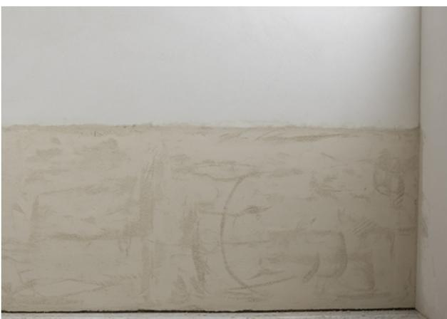
Après stabilisation complète de **FASSA ONE DRY**, l'intervention se poursuit avec l'application d'un enduit de finition respirant au choix parmi S 605, BIO-INTONACO FINE, FINITURA 750 ou FINITURA IDROFUGATA 756. Le cycle est complété par l'application d'une finition décorative et protectrice hautement respirante.
