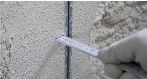
**FASSA ONE DRY** s'applique sur des épaisseurs minimales de 20 mm (au moins 30 à 40 mm recommandés). Pour les épaisseurs supérieures à 30 mm, l'enduit doit être appliqué en plusieurs couches successives, chaque couche étant appliquée après la prise de la couche inférieure. Cette dernière doit être tenue rugueuse et doit donc être dressée sans comprimer le produit.
