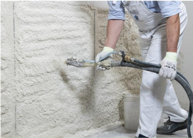
Dans le cas d'une opération manuelle, verser le produit dans la quantité d'eau propre correspondante et mélanger avec un agitateur mécanique pendant 3 à 4 minutes jusqu'à obtention d'une gâchée de la consistance souhaitée. Dans des conditions thermiques et hygrométriques normales, la gâchée doit être utilisée dans les 45 minutes.
