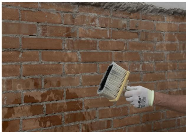
Appliquer **FASSA ONE DRY** après avoir humidifié la surface de pose, en évitant toutes stagnations en surface ou ruissellements. Les surfaces peu absorbantes, telles que certains types de maçonnerie en pierre et les surfaces en béton, doivent d'abord être traitées avec le gobetis d'accrochage S 650.
