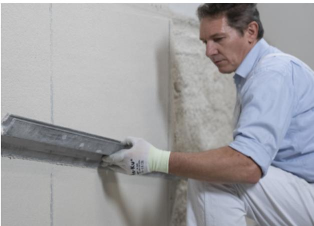
Après l'application, **FASSA ONE DRY** doit être dressé à la règle en H ou au couteau avec des passages horizontaux et verticaux jusqu'à atteindre une surface plane.
