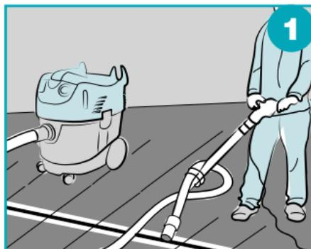
Eseguire un'accurata pulizia del giunto per rimuovere ogni traccia di impurità come polvere, sporco, oli, grassi, cere, materiali antiaderenti in genere, ecc. Vetri, metalli e altre superfici inassorbenti devono essere preventivamente pulite con del
