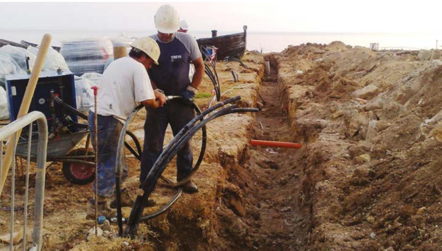
Le SGV sono utilizzate sia per estrarre energia termica dal terreno (modalità impianto in riscaldamento), sia per dissipare energia termica nel sottosuolo (modalità impianto in raffrescamento). Un impianto geotermico ben progettato e realizzato, dovrà il più possibile attutire le anomalie termiche indotte nel terreno, con un opportuno
