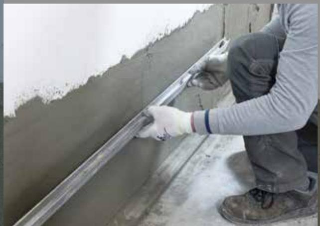
Den Zyklus nach Aushärtung des Putzes mit einer Armierspachtelung mit **FASSA K-OVER PLUS 3.30** und dem alkalibeständigen Glasfaserarmierungsgewebe **FASSANET MAXI** abschließen, um den Sockelbereich dem bestehenden, entsprechend vorbereiteten Putz anzugleichen.
