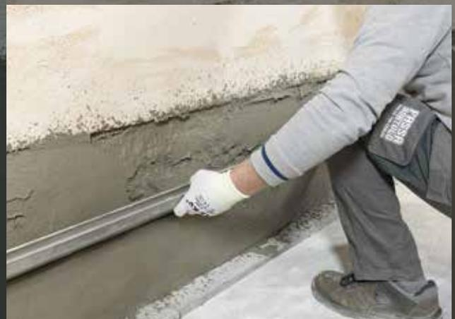
Den Zyklus nach Aushärtung des Putzes mit einer Armierspachtelung mit Mamoreffektputz, z. B. **FINITURA 750** oder **S 605** und dem alkalibeständigen Glasfaserarmierungsgewebe **FASSANET 160** abschließen, um den Sockelbereich dem bestehenden Putz anzugleichen.
