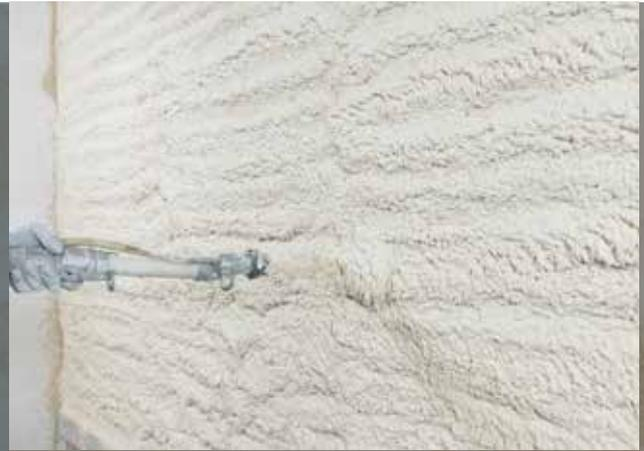
Dann oberflächenbündig direkt am Mauerwerk **KZ 35 ZOCCOLATURA SOLFATORESISTENTE** über eine Höhe von zirka 30 bis 40 cm und mit einer Dicke von 1 bis 2 cm (entsprechend der des Putzes oberhalb des Sockelbereichs) von Hand oder mit der Putzmaschine auftragen.
