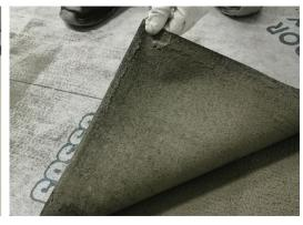
Regolare la quantità di collante in modo da ottenere la corretta bagnatura del telo; un eccesso di adesivo porta alla formazione di increspature e ondulazioni.
