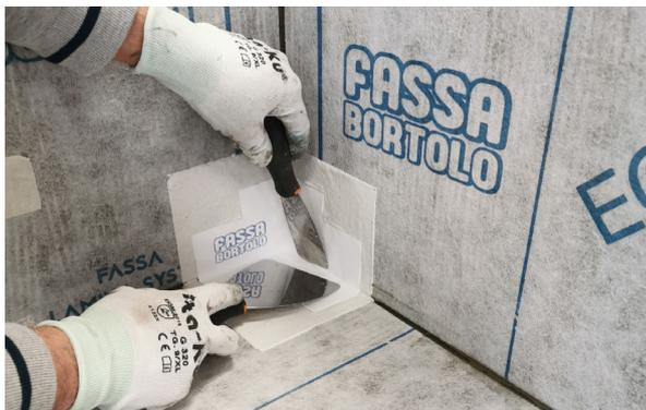
Sigillare quindi tutte le giunzioni tra i teli con la bandella AQUAZIP ELASTOBAND; stendere lo speciale adesivo impermeabilizzante AQUAZIP LAMINA FIX mediante la parte liscia della spatola lungo tutto il perimetro, sia sulla superficie orizzontale sia verticale su una fascia alta circa 10 cm; la stessa operazione dovrà essere effettuata in corrispondenza dell'angolo parete-parete.
