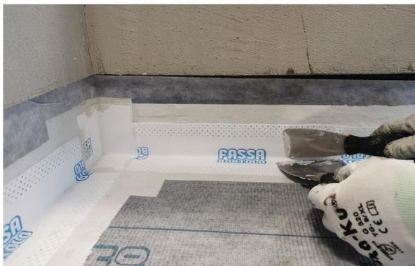
Compléter le traitement de tous les points critiques en appliquant AQUAZIP LAMINA FIX sur l'accessoire AQUAZIP ELASTOBAND sur au moins 6 cm, 3 cm sur l'accessoire et 3 cm sur la membrane.
