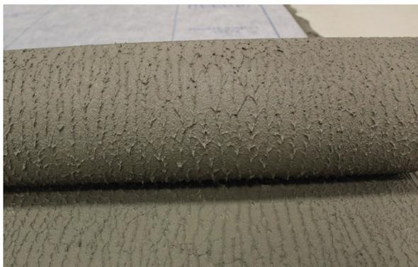
Il n'est pas nécessaire de respecter les joints de fractionnement existants. Les joints de dilatation doivent être réalisés sur le revêtement conformément aux indications des normes en vigueur ; les joints structuraux, en revanche, doivent être respectés.
