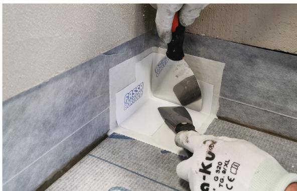
Ensuite, sceller toutes les jonctions entre les feuilles avec la bande **AQUAZIP ELASTOBAND** ; étaler la colle d'imperméabilisation spéciale **AQUAZIP LAMINA FIX** avec le côté lisse de la truelle sur tout le périmètre, tant sur la surface horizontale que verticale, sur une bande d'environ 10 cm de haut. Appliquer la colle d'imperméabilisation également en correspondance des accessoires précédemment installés sur environ 5 cm.
