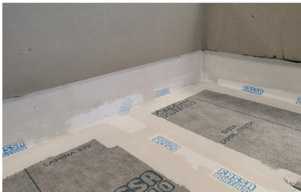
Dans le cas de traitement de relevés verticaux en présence de membranes bitume-polymère, la procédure est la suivante.
